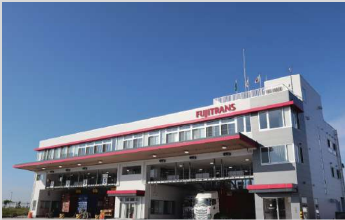
FTC 西浜コンテナ
