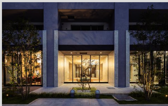
レーベン本厚木 集合住宅 新築 THE MASTERS TOWER 構造・規模 RC 造 19 階建 Atugu Kanagawa JP 延床面積 9,973 m 2 事業主 タカラレーベン
