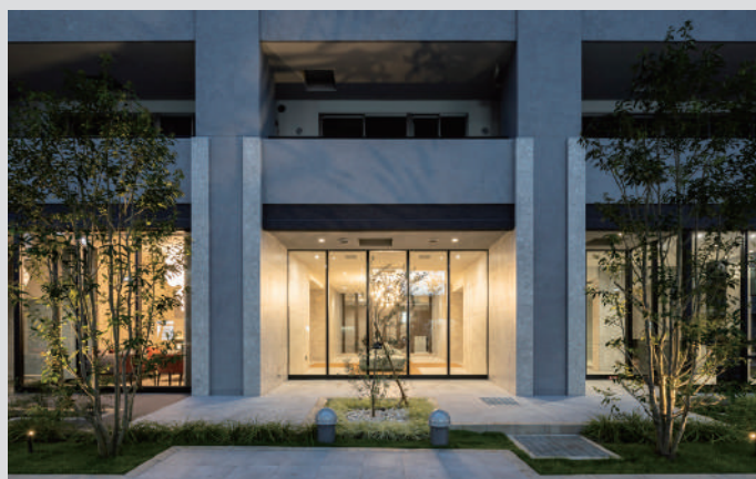
レーベン本厚木 THE MASTERS TOWER 集合住宅 新築 Atugu Kanagawa JP 構造・規模 RC 造 19 階建 延床面積 9,973 m 2 事業主 タカラレーベン
